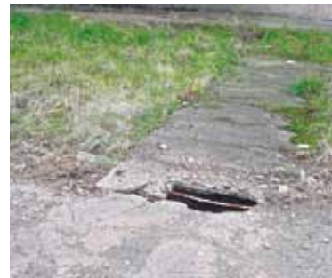
▲ Poškozený chodník – propadá část není zabezpečena.
