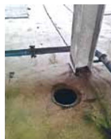
▲ Nezájištěný otvor v podlaze (např. chybějící víko kanálu, otvor po demontáži technologického zařízení atp.)
