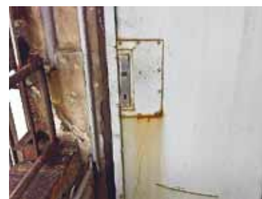
▲ Poškozený, v tomto případě chybějící ovládací mechanismus dveří. Jedná se o poměrně častý jev, který v případech, kdy se jedná o dveře únikového východu, může způsobit závažné škody.
