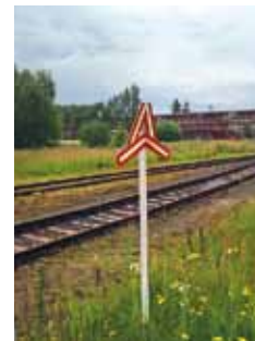
▲ Poničené vislé dopravní značení.
