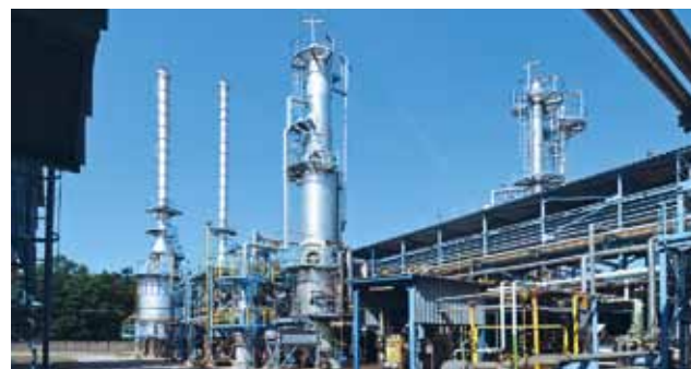
▲ V jednotce hydrogenačního odsíření středních destilátů pardubické rafinerie se letos podařilo rozšířit výměňková pole a zvýšit tak energetickou účinnost procesu odsíření motorové nafty.
