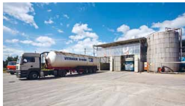
▲ Čistící a pařící stanice Unipetrolu Doprava.
