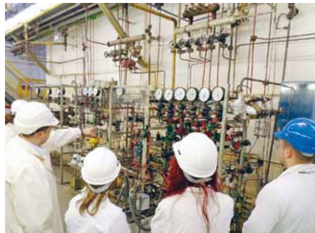
↑ Vedoucí pokusné základny Robert Pretschner vysvětluje návštěvníkům z mostecké pobočky VŠCHT, jak se na vstupech do reaktorových jednotek nastavují jednotlivé parametry (průtoky procesních plynů, tlaky v jednotce) a ukazuje, kde se odebírají výstupní vzorky.
