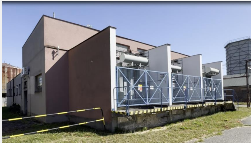
Budova energetiky – výrobní areál Kolín
