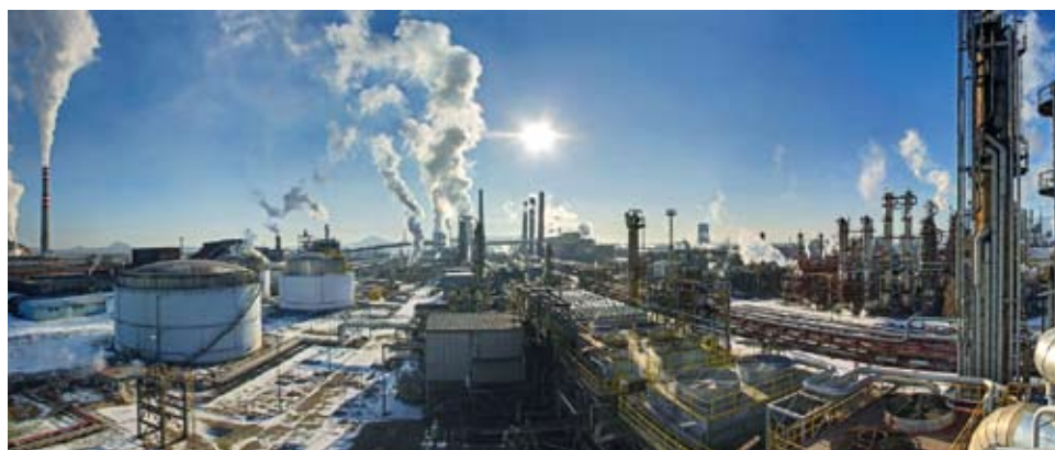
▲ Pohled na část rafinerie v Chemparku Záluží.
