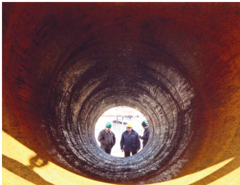
▲ Při kontrole vrchní části komína pece atmosférické destilace ropy se odborníci shodli na nutnosti nového vnitřního nátěru.
