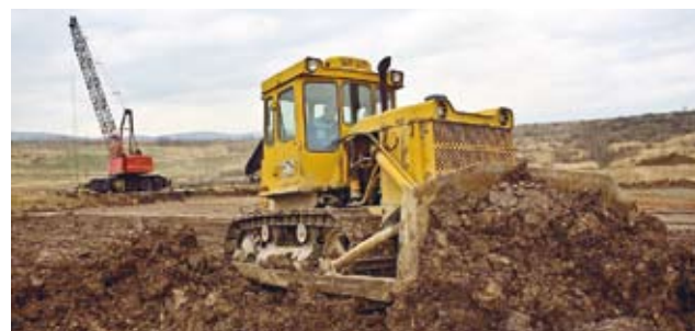
▲ Historický snímek dokládá průběh zemních prací na vytěžené laguně R3.
