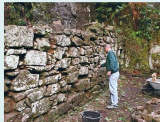
▲ Pracovníci VÚAnChu vyvinutá malta bez cementu byla zkušebně použita při opravě zdi kostela Svaté Kateřiny v Bořislavi a rovněž na obvodové zdi staré pekárny u Dolského mlýna (autor tří snímků Petr Antoš).
