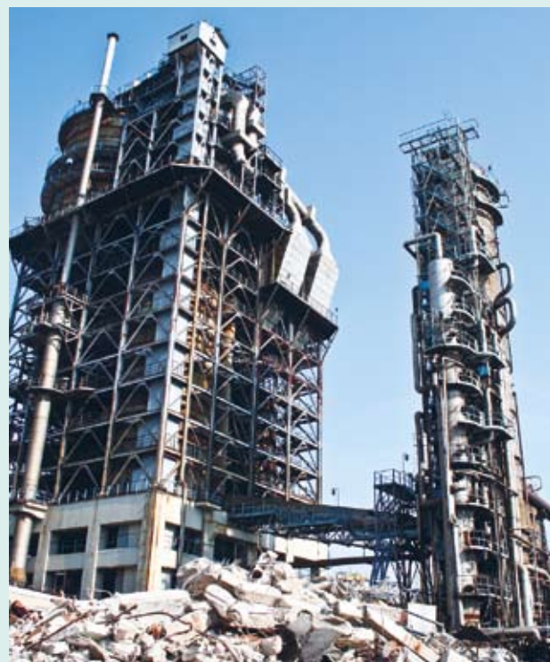
▲ V Płocku demontují krakovací jednotku.
