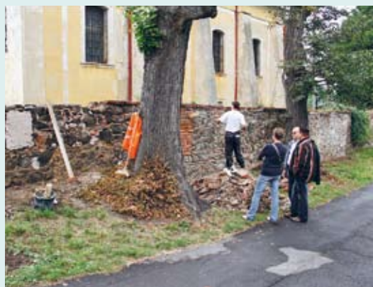
▲ Pracovníci VÚAnChu vyvinutá malta bez cementu byla zkušebně použita při opravě zdi kostela Svaté Kateřiny v Bořislavi a rovněž na obvodové zdi staré pekárny u Dolského mlýna (autor tří snímků Petr Antoš).
