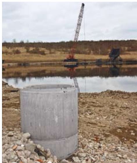
▲ V popředí je sanační jímka, která bude sloužit ke kontrole podzemních vod ve vytěžené laguně R4.
