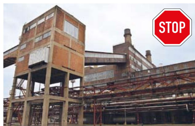
▲ Pohled na teplárnu T200 ze severní strany.
