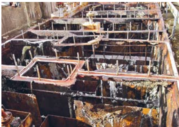
▲ Sírná jímka byla po deseti letech provozu napadena korozi. Na její původní očištěnou konstrukci proto byl upevněn nový plášť z 3 milimetrových nerezových plechů.
