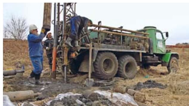
▲ V rámci průzkumných prací byly západně od laguny R4 vybudovány tři vrty, aby se zjistil aktuální stav podloží.
