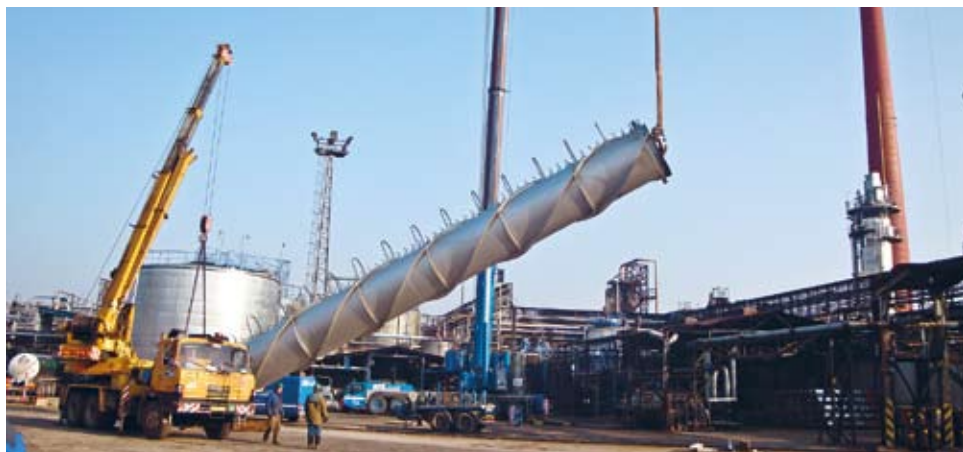
▲ Vrchní díl komína pece atmosférické destilace ropy byl sundán za pomoci jeřábu firmy APB Plzeň.
