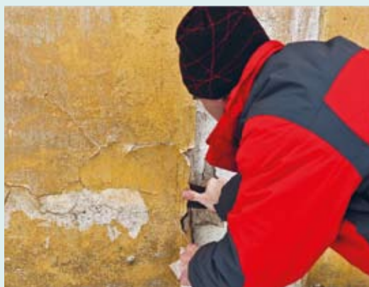
▲ Pracovníci VÚAnChu vyvinutá malta bez cementu byla zkušebně použita při opravě zdi kostela Svaté Kateřiny v Bořislavi a rovněž na obvodové zdi staré pekárny u Dolského mlýna (autor tří snímků Petr Antoš).
