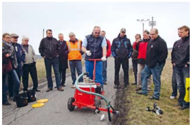
▲ Aplikace Gumoasfaltu SF pojezdným zařízením Spáromat.
