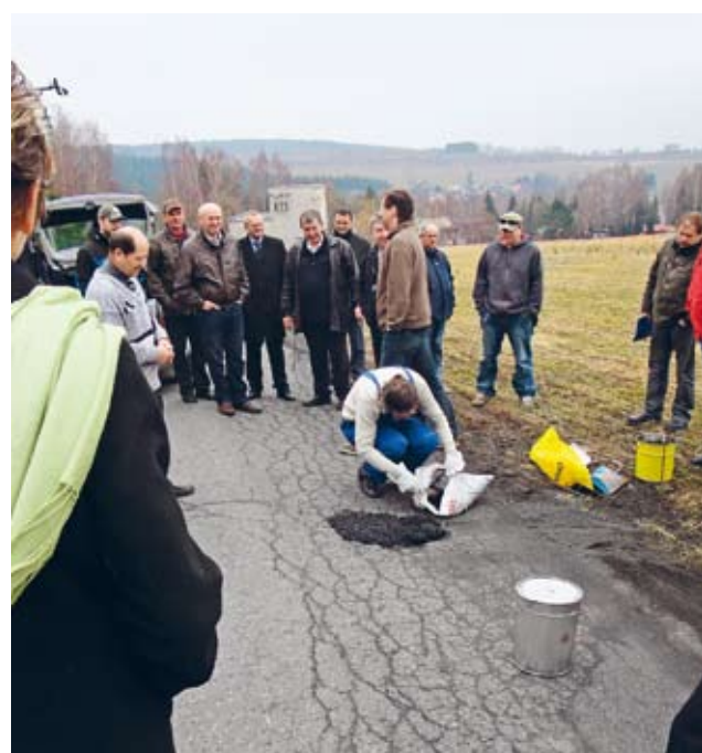
▲ Opravu výtlučku předvedl Jaroslav Petříček z odboru vývoje paliv a asfaltů.
