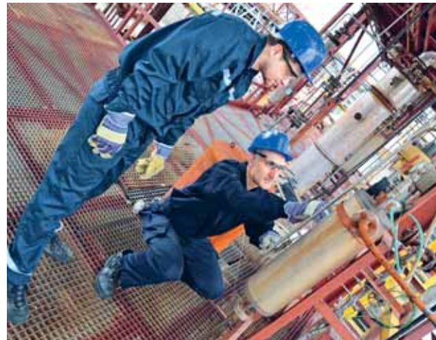
▲ Dušan Kovač (stojící) s kolegou Waltrem Posledním zjišťují u poloprovozní jednotky POX rozsah potřebných úprav pro použití suroviny z katalytického krakování při výrobě vodíku v Unipetrolu RPA. Ta částečně nahradí klasicky používaný visbreakový zbytek.
