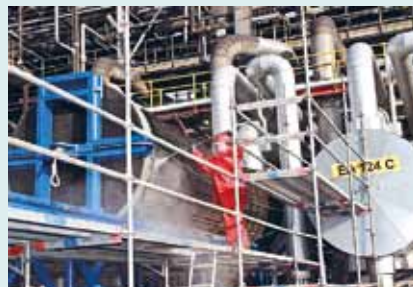
▲ Vysunutí a po vyčištění i vrácení na místo šedesátitunového trubkového svazku není jednoduchou záležitostí.
