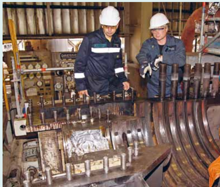
▲ U demontovaného kompresoru GB-201 etylenové jednotky zjišťují aktuální situaci Václav Kaška, vedoucí odboru údržby Unipetrolu RPA, a Petr Kořán, vedoucí oddělení údržby strojů.
