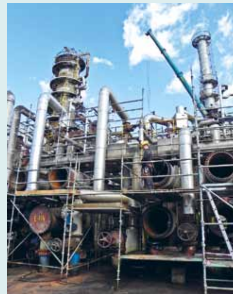
▲ Součástí zarážky komplexu NRL (Nová rafinerie Litvínov) je čištění a inspekce výměníkové řady.
