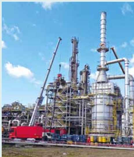
▲ Na jednotce hydrokrakování byla prováděna mimojiné výměna katalyzátoru.
