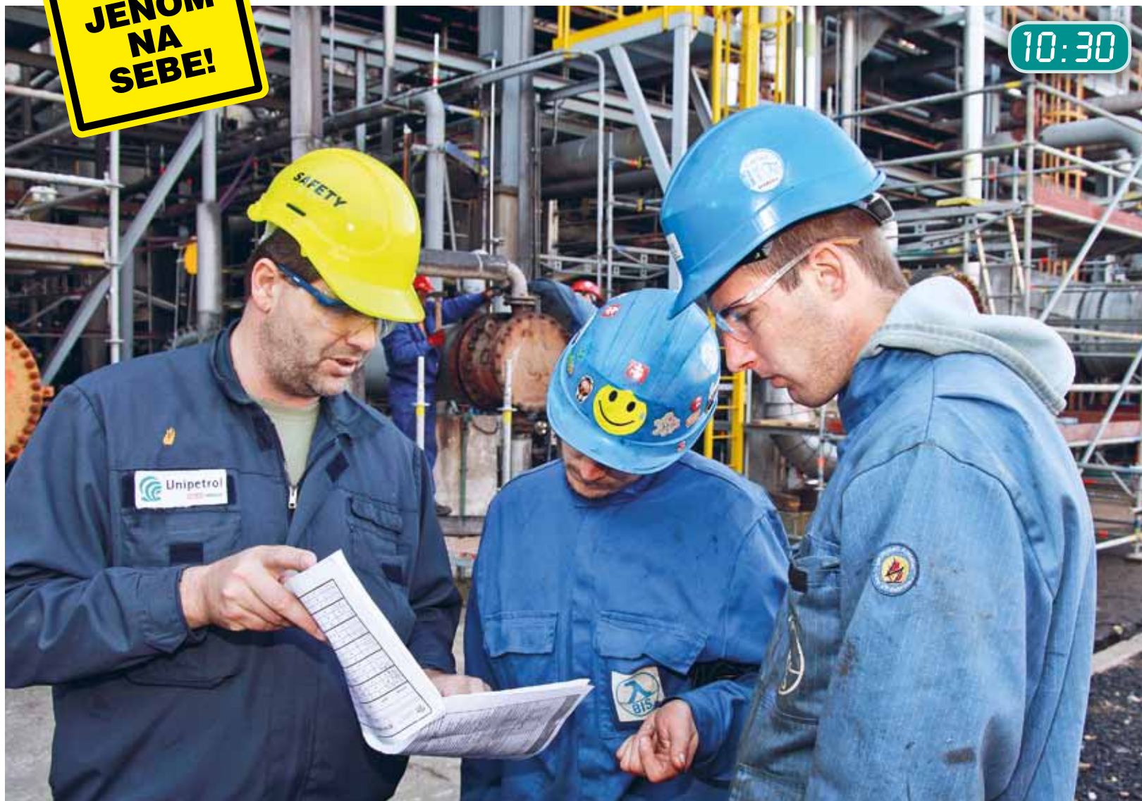
▲ Prověrka povolení k práci v úseku dělení pyrolyzních plynů, kde probíhá tlaková zkouška propylénového chladiče EA-209 na výtlačku pyroplynového kompresoru GB-201.
