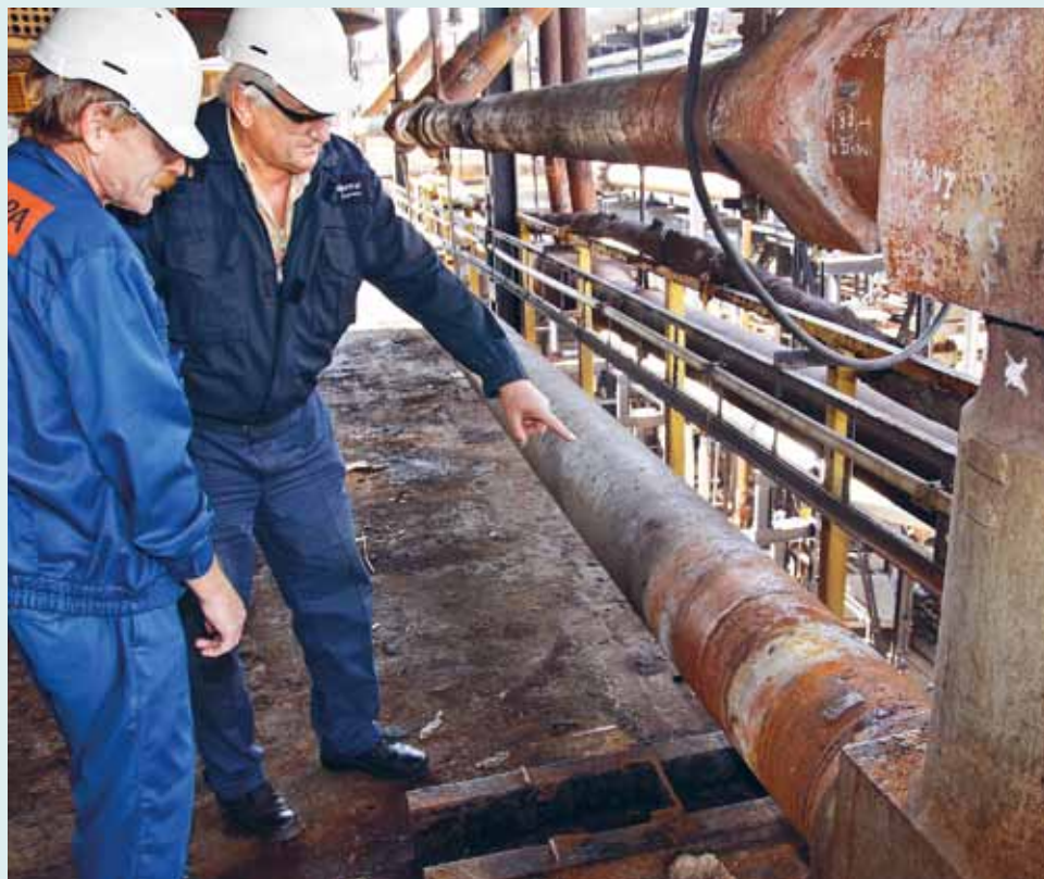
▲ Karel Strážnický, vedoucí sekce údržby AGRO, spolu s vedoucím výroby čpavku a močoviny Janem Konrádem kontrolují jeden z dvanácti opravovaných svarů na vysokotlakém čpavkovém potrubí.
