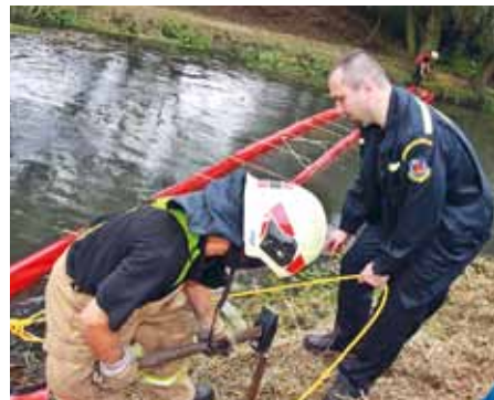
▲ Při instalaci testované normy stěny asistovali hasiči Unipetrolu RPA.
